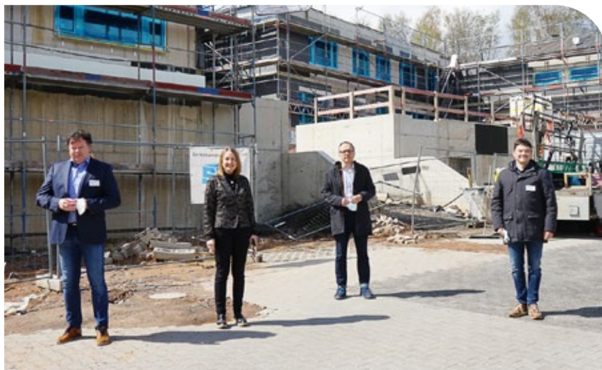
Bei der Baustellenbesichtigung (v.l.n.r.): SHG-Geschäftsführer Bernd Mege, Baudirektorin Marianne Thömes, Verwaltungsdirektor Dr. Martin Huppert und der stellvertretende Projektleiter Martin Hartmann.
