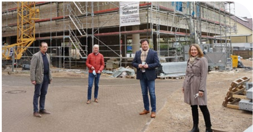
Bei der Baubesichtigung (von rechts): SHG-Baudirektorin Marianne Thömes, Geschäftsführer Bernd Mege, Verwaltungsdirektor Edgar Mertes und Bauleiter Marcus Kessler.
