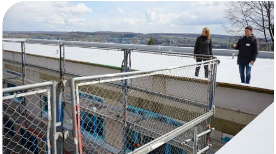
Auf dem Flachdach des zweistöckigen Neubaus oben auf dem Sonnenberg.
